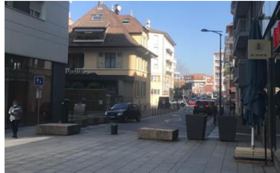
Figure 22 : Vue de l'accès à la zone piétonne Chablais Parc - avec le dispositif de borne rétractable – depuis la rue des Alpes
