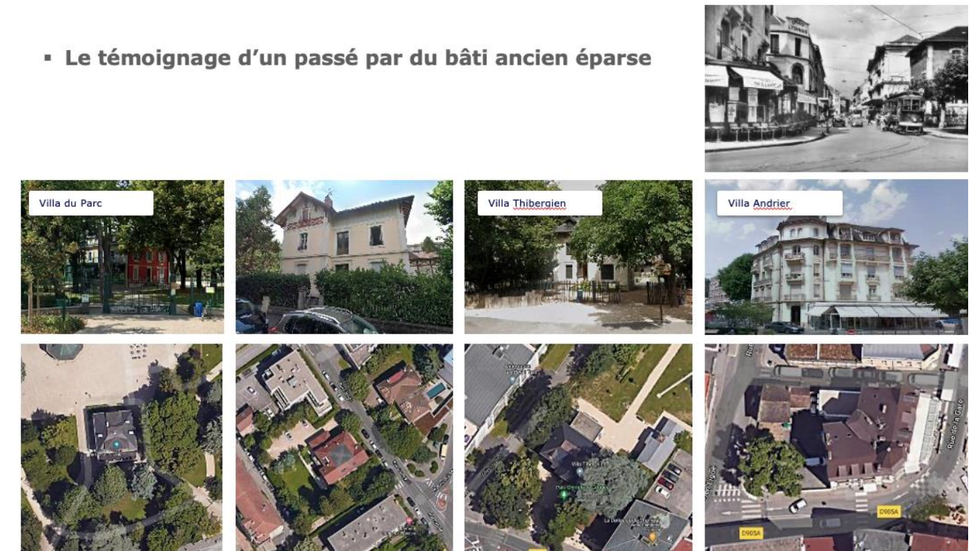
Figure 12 : Vues des villas et immeubles « Belle époque » du centre-ville
