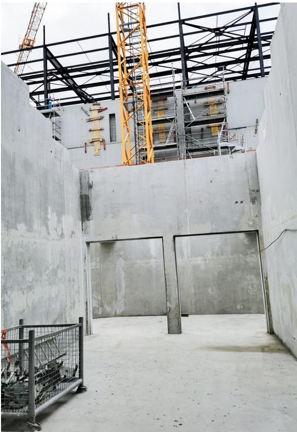
Entrée de la salle avec mise en place des futurs gradins
