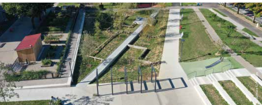
Le parking Clemenceau avant sa transformation en parc.
